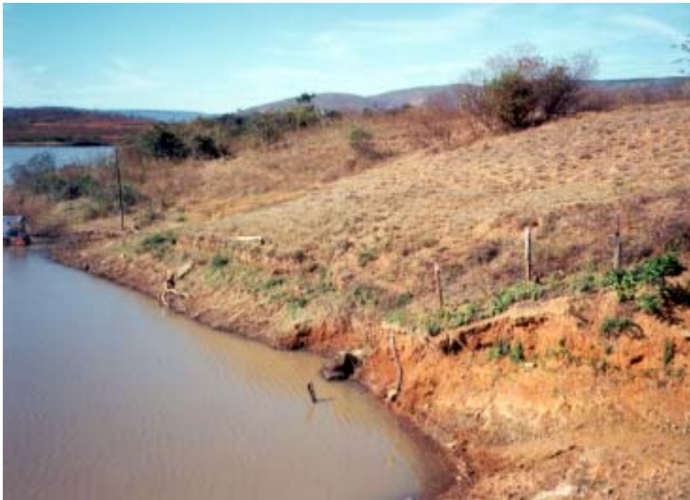
Vista da barragem do Calhauzinho: projeto objetivo melhorar o aproveitamento dos recursos hídricos e a preservação ambiental da sub-bacia do rio homônimo, em Minas
