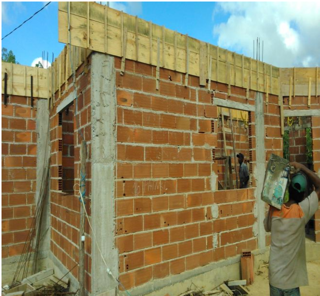
Foto 02 – Pedreiros trabalhando no preparo da laje.
