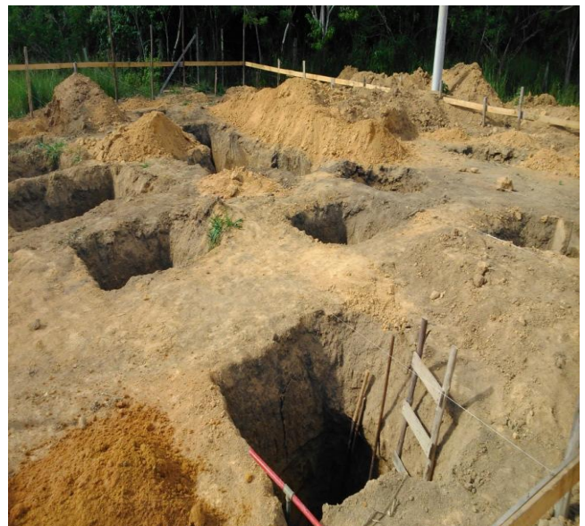
Foto 04 – Preparo das sapatas da 14ª casa.
