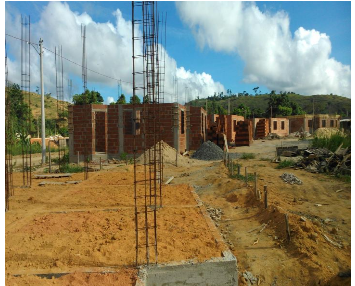
Foto 03 – 12ª casa em preparo do piso armado.
